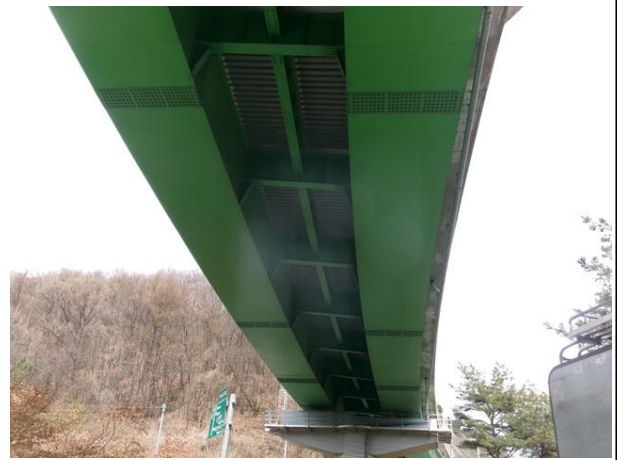
바닥판 하면 및 거더 전경
