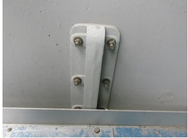
점검통로 고정장치 상태양호 P2
