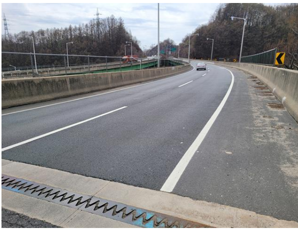
교량 상부 전경
