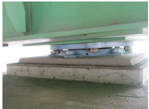
받침장치 상태양호 P2-SH1
