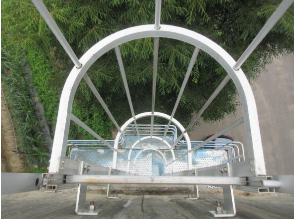
점검사다리 상태양호 P2
