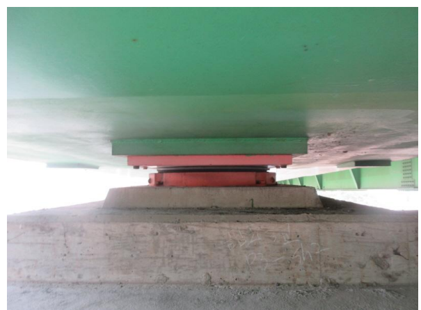
받침장치 상태양호 P3-SH2
